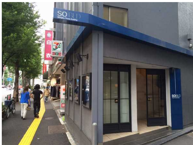
ビル1F入口
